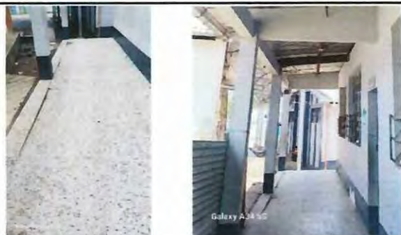
FOTO 5: SUSTITUCION DE PISO EN MAL ESTADO EN CORREDOR POR CERAMICO ANTIDESLIZANTE
