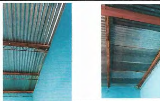
FOTO 2: CAMBIO DE ESTRUCTURA DE TECHO DE MADERA A METALICA EN AULAS Y PASILLO
