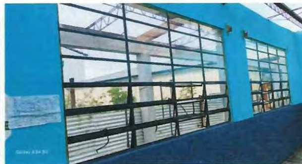
FOTO 4: MEJORAMIENTO DE ESTRUCTURA METALICA DE VENTANAS DE AULAS
