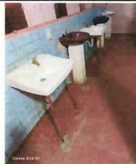
FOTO 10: APLICACIÓN DE PINTURA EN TOTO EL ESTABLECIMIENTO
