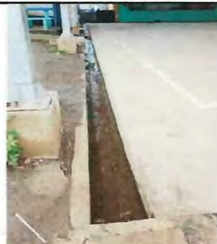
FOTO 12: INSTALACION DE REJILLA DE METAL A CUNETETA DE CONCRETO
