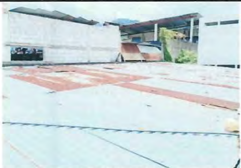
FOTO 1: CAMBIO DE CUBIERTA DE LAMINA A LAMINA TROQUELADA A AULAS Y PASILLO
