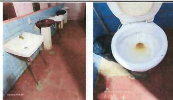
FOTO 8: SUSTITUCION DE LAVAMANOS E INODORO
