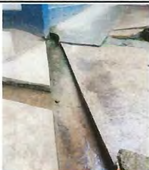
FOTO 11: INSTALACION DE REJILLA DE METAL A CUNETETA DE CONCRETO
