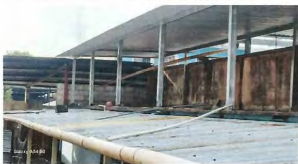
FOTO 7: INSTALACION DE CANALES Y BAJANTES DE AGUA PLUVIAL DIRECCIONANDO EL AGUA EN EL TINACO QUE SE COMPRARA
