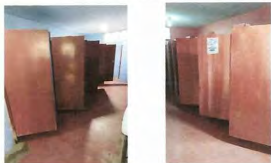
FOTO 3: SUSTITUCION DE PUERTAS DE MADERA POR PUERTAS DE METAL EN BAÑOS Y DIRECCION
